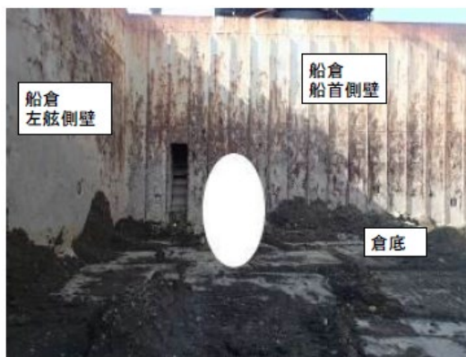
船倉の船首側の倉底及び隅の残土の状況
